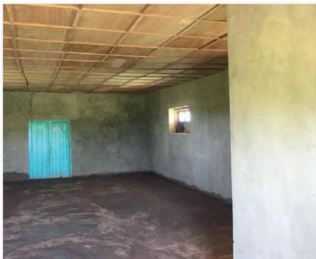
Foto 5: la sala degenze con posa calcestruzzo, intonaco e soffitto terminato.
